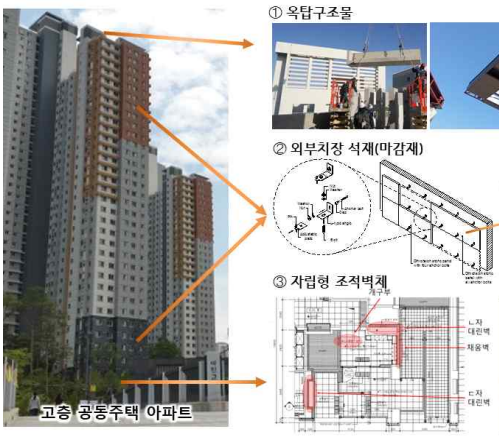
[그림 3] 고층 아파트 비구조재 설치현황
