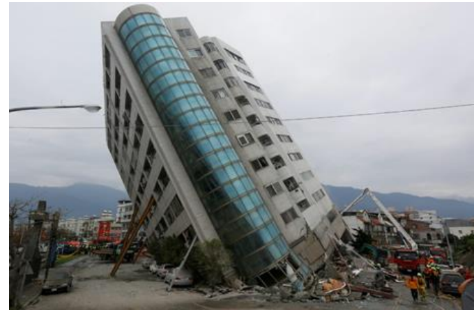
대만 화롄 지진시, 지하층 파괴로 인한 기울어짐
